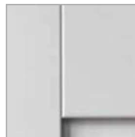
fazowanie krawędzi na połączeniu ramiaków
