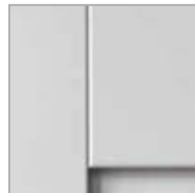
fazowanie krawędzi na połączeniu ramiaków
