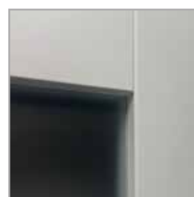
połączenie ramiaków pionowy z poziomym
